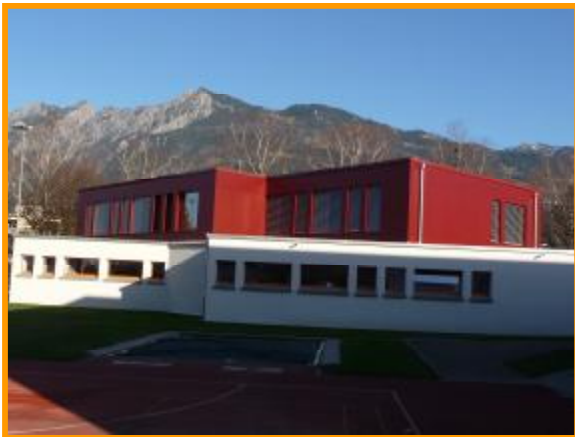
Aufstockung Holzelementbau Kindergarten Galstramm Sevelen
