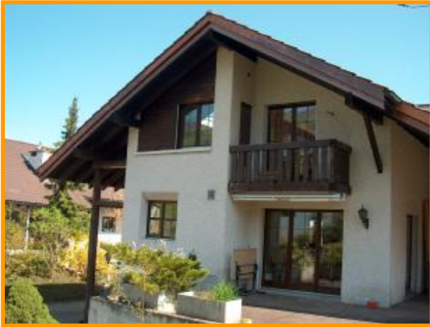
Innenausbau mit Carport Bärlocher in Grabs
