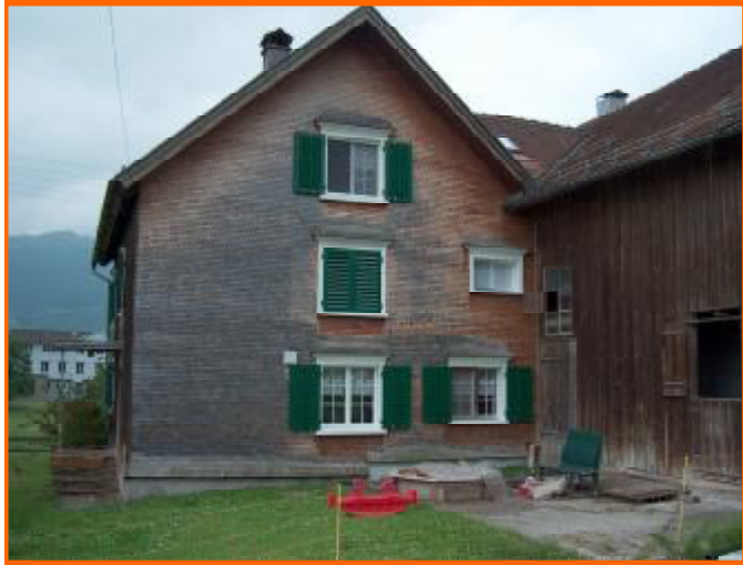
Eingangsbereich vor Umbau Sturzenegger in Grabs
